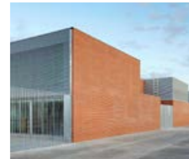
208 CEIP SANT BERNAT Olesa, Spain Project 2003
